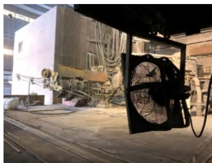
ภาพที่ 3.2.5.3-4 การติดตั้งพัดลมสำหรับระบายอากาศ
